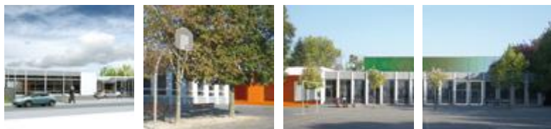
L'école Jean Mermoz après travaux (parvis et cour de l'école)
