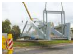
Montage de la passerelle
