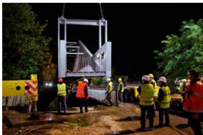
Dans la nuit du 13 au 14 octobre, pose de la passerelle.
