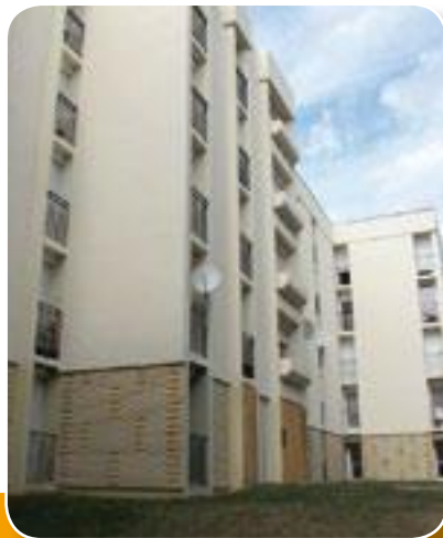
Travaux en cours d'achèvement visuel : Logélia Charente.
