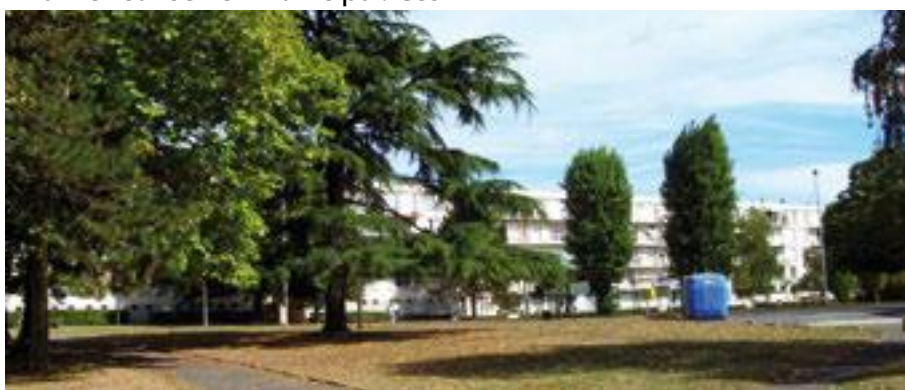
Vue du parvis à réaménager
