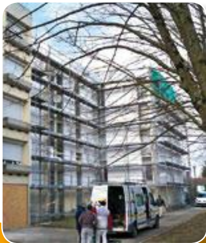
Immeuble « KALIS », pendant les travaux. visuel : Logélia Charente.
