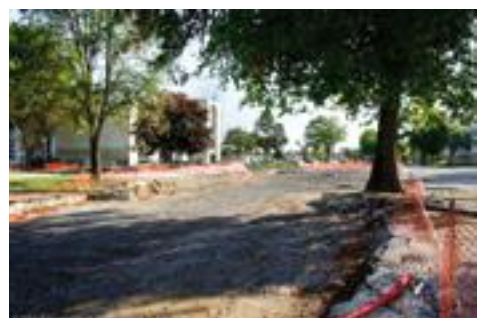
Vue du chantier Basseau sud
